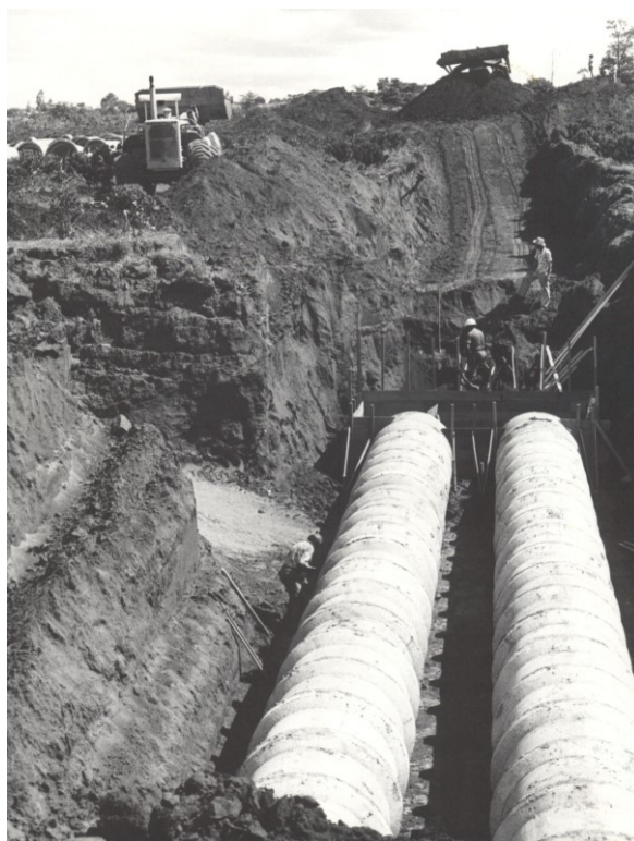
Figura 5 - As galerias de águas pluviais, construídas para conter as erosões no Parque das Grevíleas
